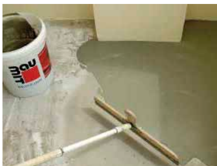
Lattioissa, takista ja korjaa kaadot.
