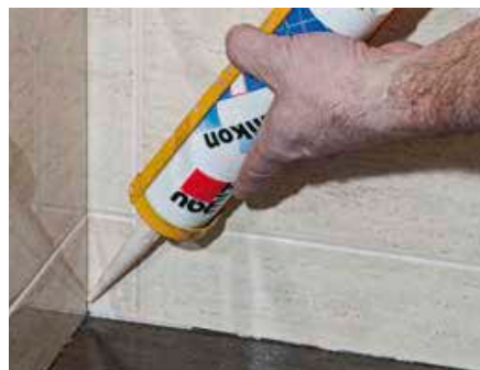
Täytä kulmasaumot Baumit Silokonmassalla, varmista, että saumat ovat kuivat ja puhtaat ennen aloitusta.
