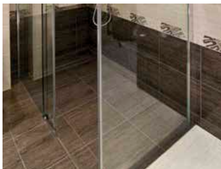
Valmis huolellisesti tehty laatoitus on käyttöön otettavissa.
